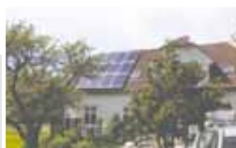
Hvaler: Installert effekt 3,1kWp
