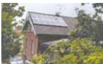
Hvaler: Installert effekt 3,1kWp
