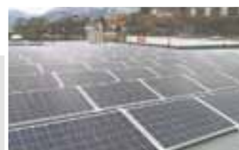
Bergen: Installert effekt 60kWp
