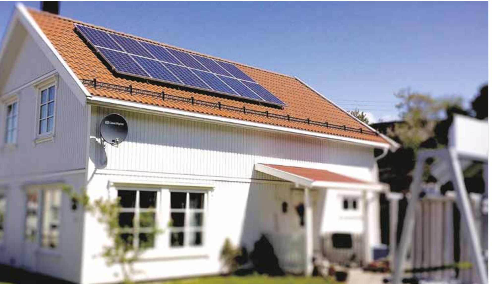
Bolighus på Hvaler med 3kW solcelleanlegg som tar 20 kvm plass på taket, og gir en årlig produksjon på dette huset på 3.691 kWh pr år. Anleggene kan også monteres helt integrert i taket. FOTO: SMART ENERGI.
