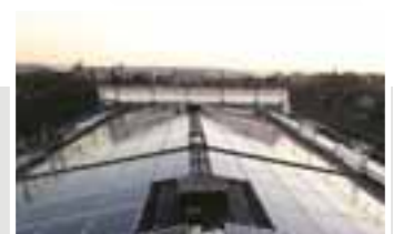
Oslo: Installert effekt 64kWp
